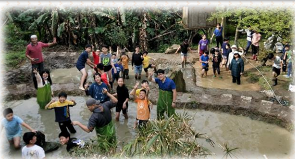
使用牛踏層的方式建造生態池
