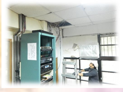
小禮堂主控室電源電線整理
