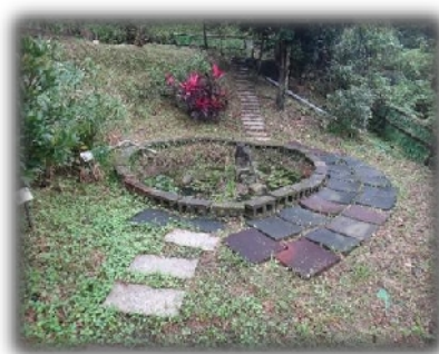
生態池清淤、地面整平， 教學步道完成
