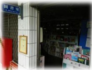
門面無特色且室內光線陰暗 (施作前)
