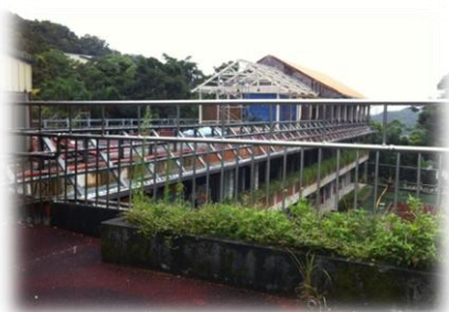
屋頂整修 (施工前)
