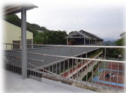
屋頂整修 (施工後)
